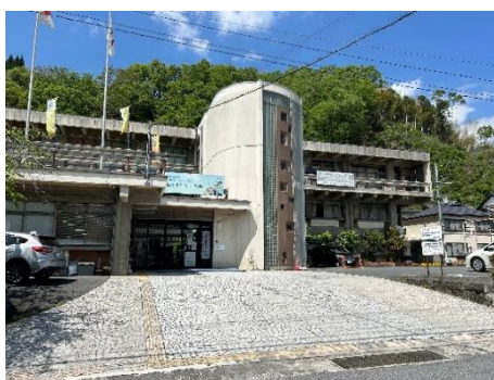
図 | 現役場の全景
