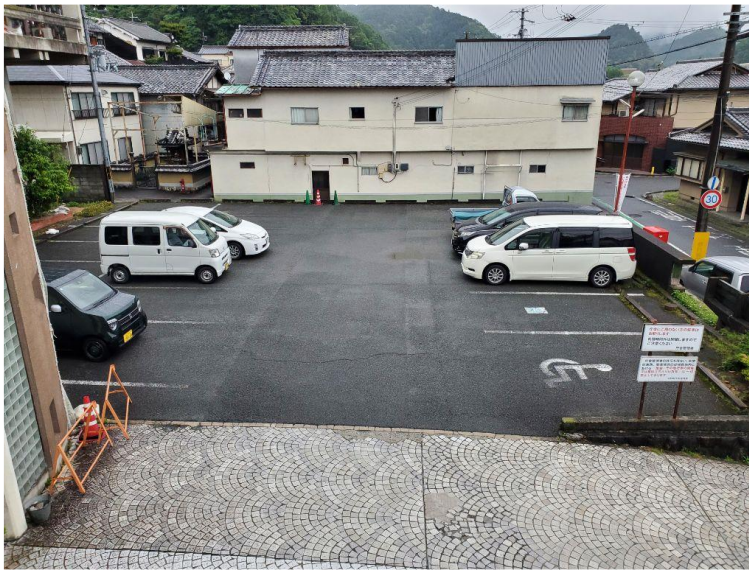
図 | 来庁者用駐車場(全景)
