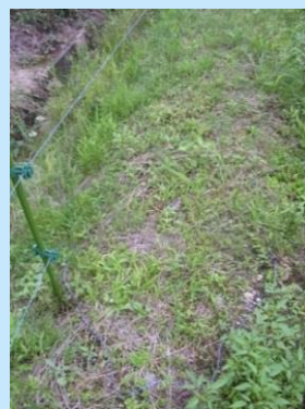
電柵の線が切れている
