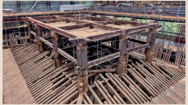
2階部分は解体され、下層(1階部分)の解体が進んでいる。
