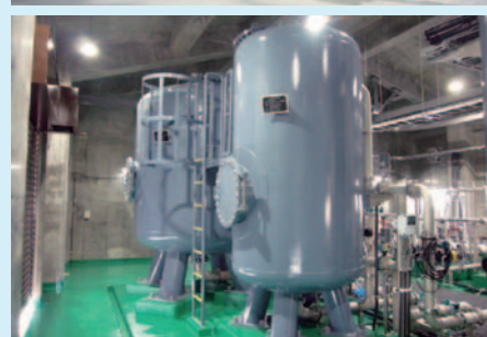
▶ 吉野山南院谷浄水場 内部
