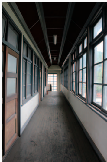
旧連合会事務所2階廊下
